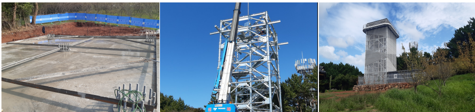
그림 3-116 콘크리트 베이스 구축, 타워 조립, 타워 및 장비실(셸터) 구축현황
