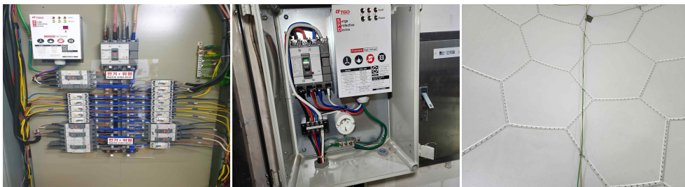
그림 3-119 분전반 교체, 서지보호장치 개선, 피뢰돌침 인하도록 개선
